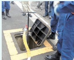
スタンドパイプによる消火訓練
