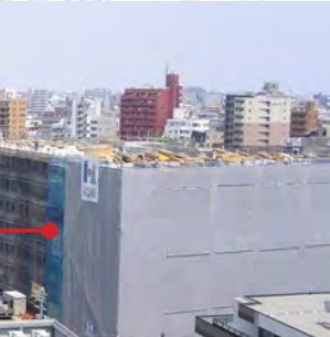
建設中のマンション
